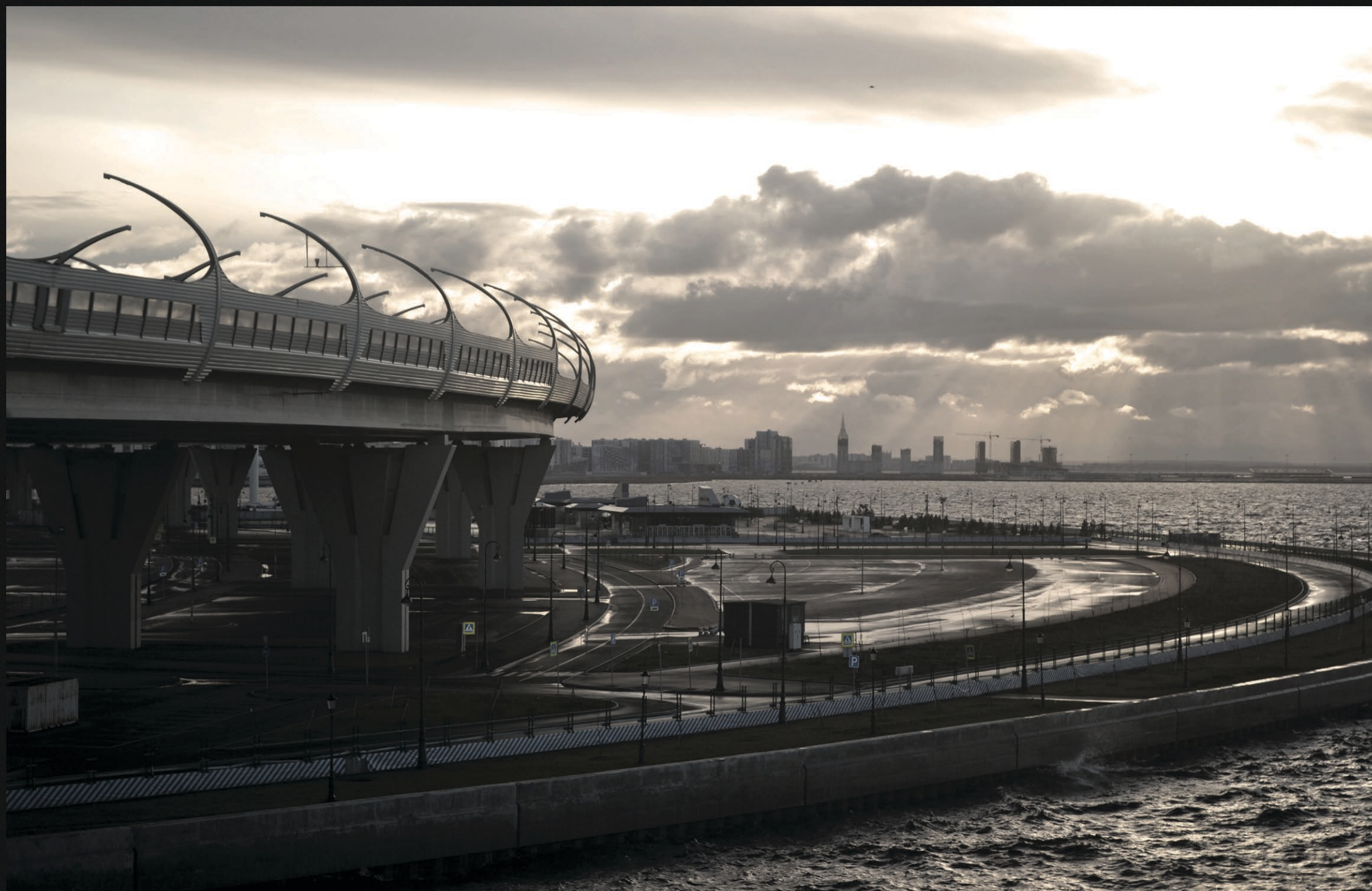
Западный Скоростной диаметр. Вид с Яхтенного моста
