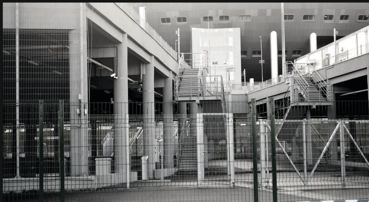
Газпром-Арена. Эвакуационные пути
