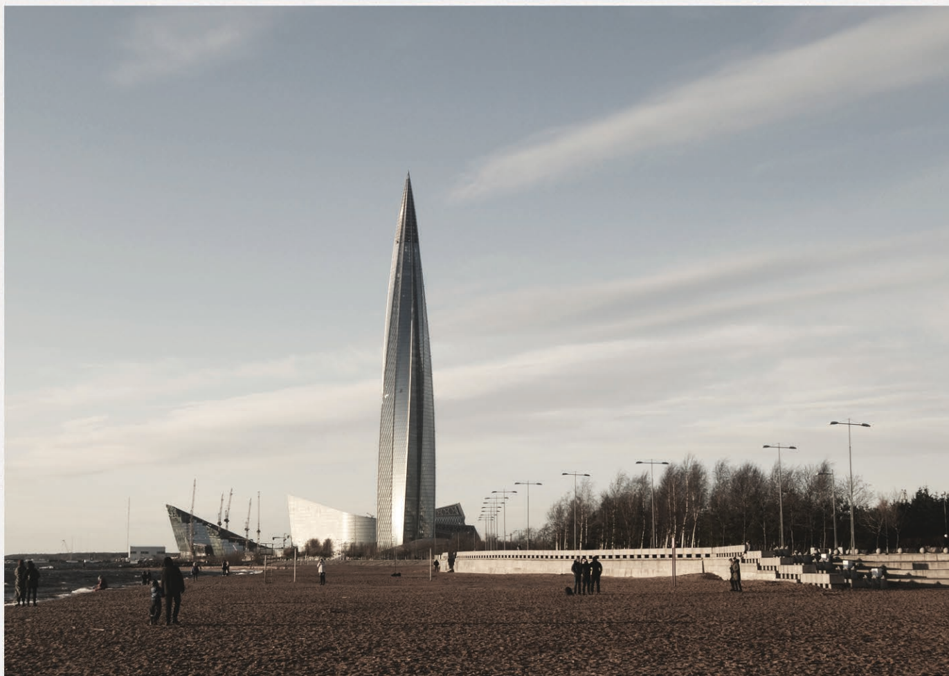
Лакhta-Центр. Вид с набережной Парка 300летия Санкт-Петербурга
